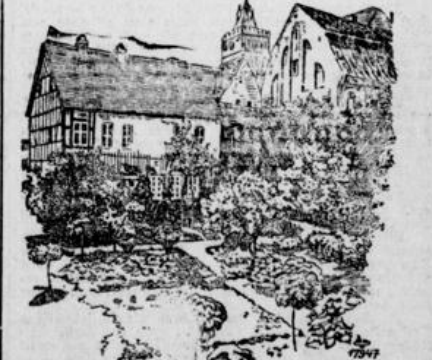
Das Geburtshaus Heinrichs von Kleist (rechts im Bild) in Frankfurt a.M., das heute nicht mehr vorhanden ist.
