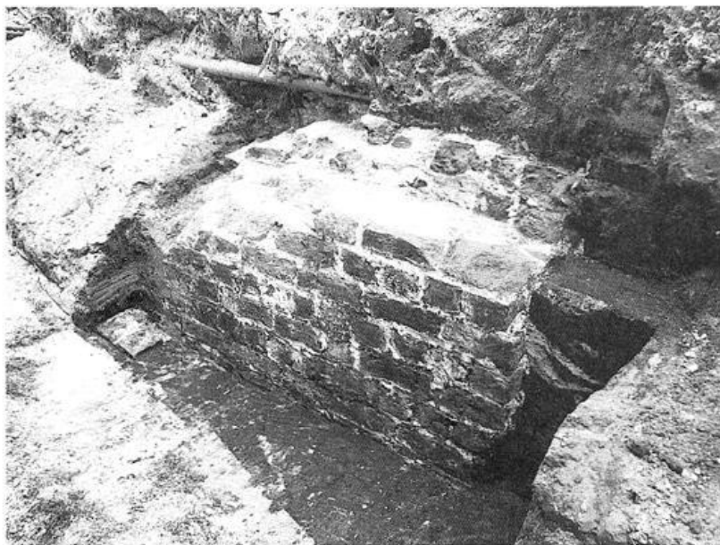
Abb. 7: Oldenburg, FStNr. 111, krfr. Stadt Oldenburg. Mittelalterlicher Mauerrrest, vermutlich Teil des nördlichen Stadtmauerzuges bzw. des Heiligengeisttores.
