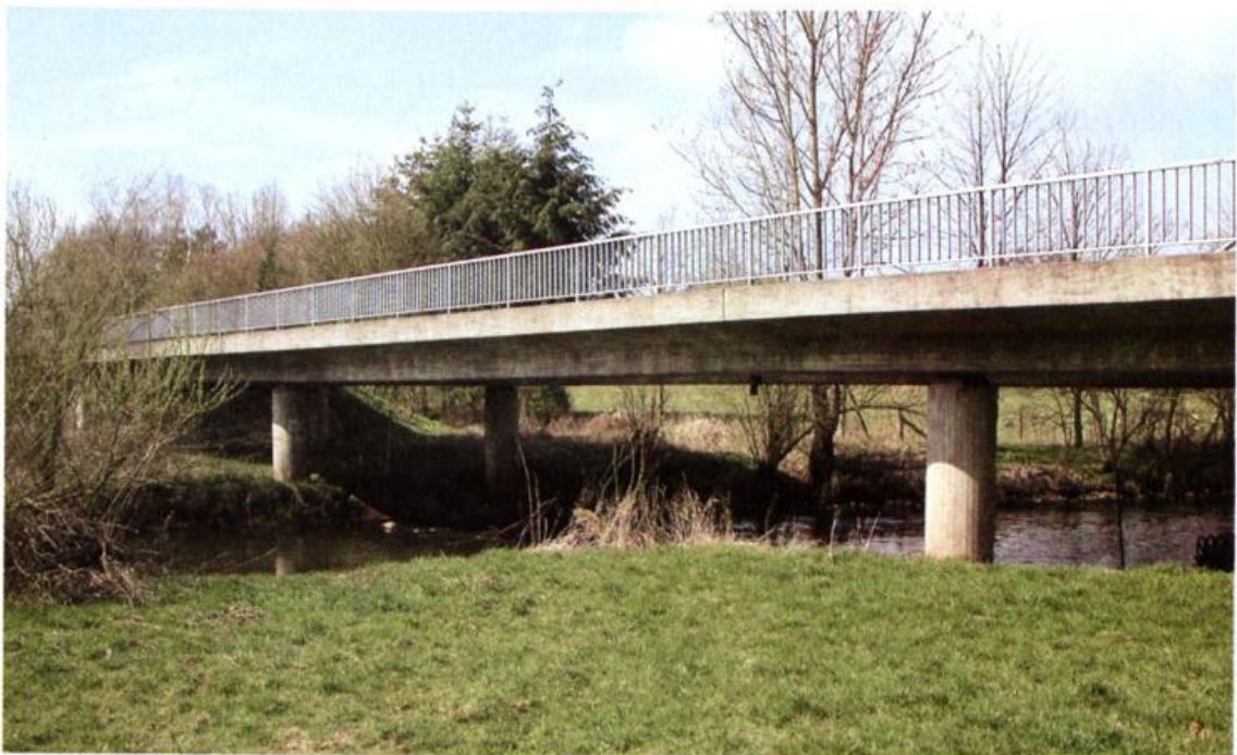
Abb. 11: Für den Fischotter wie für andere Tierarten sollten Brückenbauwerke neben dem Gewässer auch immer einen Uferstreifen mit hindurchführen.
