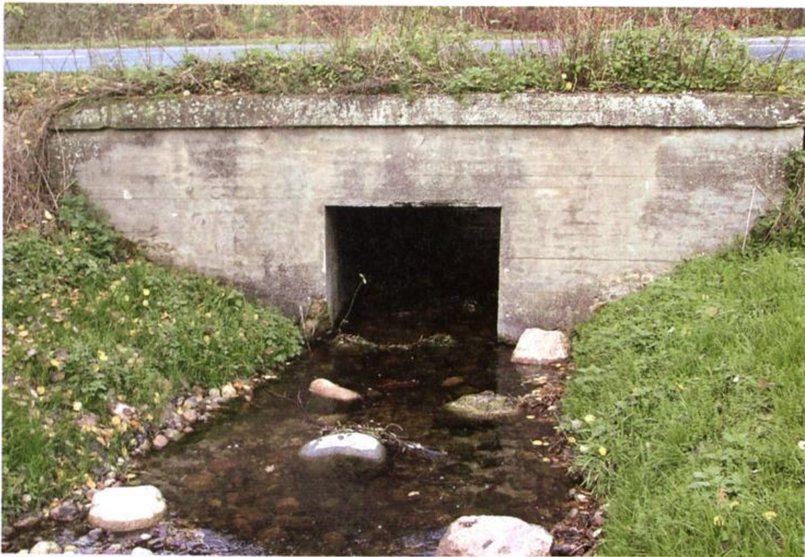
Abb. 10: Brücken, die das Gewässer ohne einen Seitenstreifen unter der Brücke hindurchführen, verleiten Fischotter zum Queren der Straße und setzen sie damit den Gefahren des Autoverkehrs aus.
