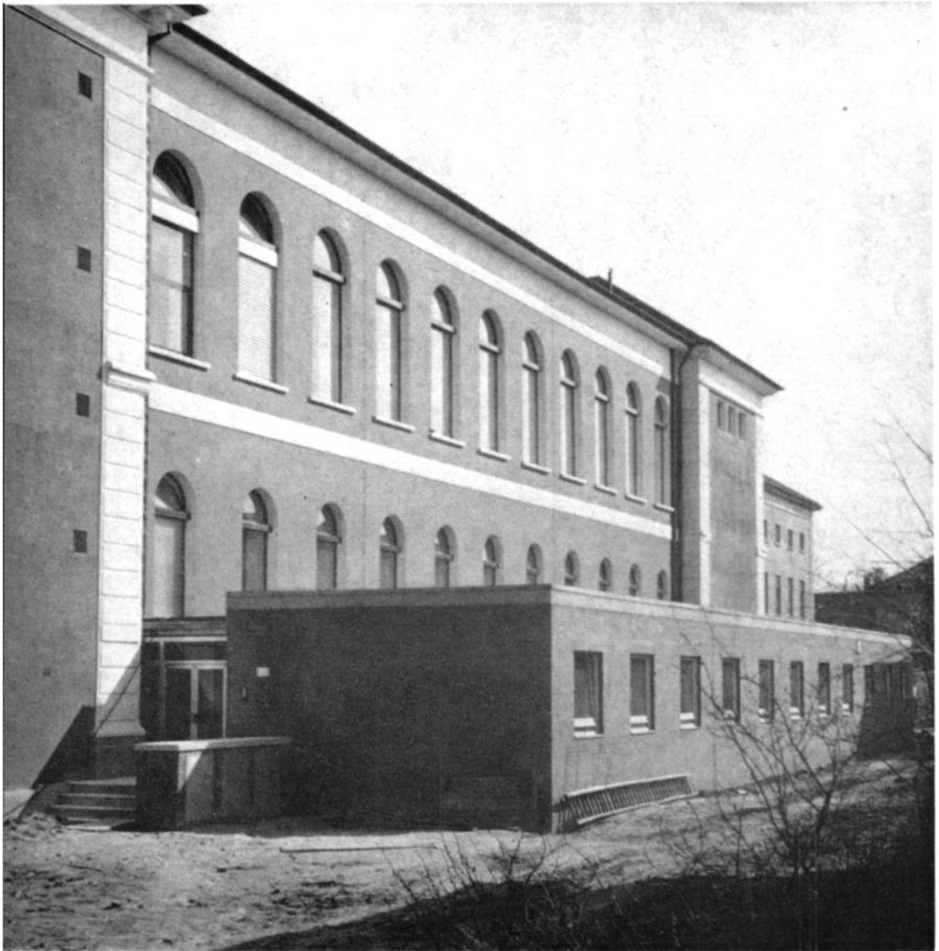
Blick auf die Rückseite des Erweiterungsbaus mit dem Trakt für Arbeitsräume und Laboratorien.
