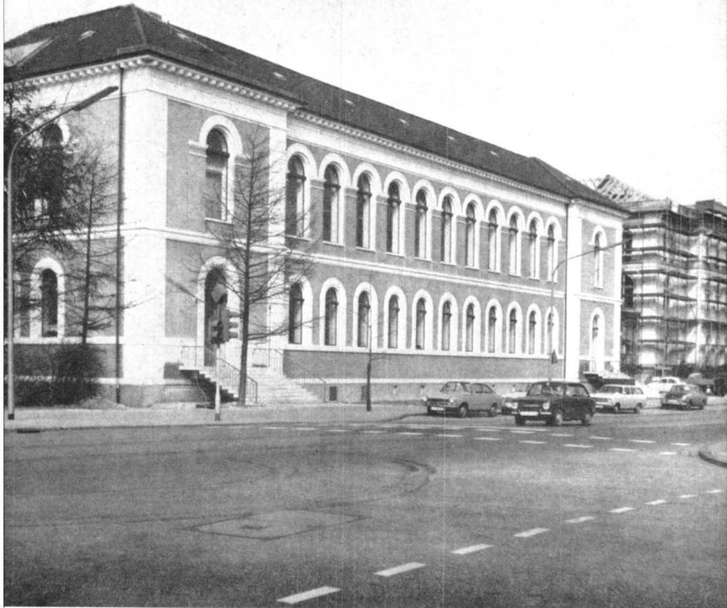
Der am 27. April 1971 eingeweihte Erweiterungsbau des Staatlichen Museums für Naturkunde und Vorgeschichte, gewonnen durch Wiederherstellung, Umbau und Ausbau des ehemaligen Landesbibliotheksgebäudes von 1845 (rechts im Gerüst das alte Museumsgebäude von 1879).
