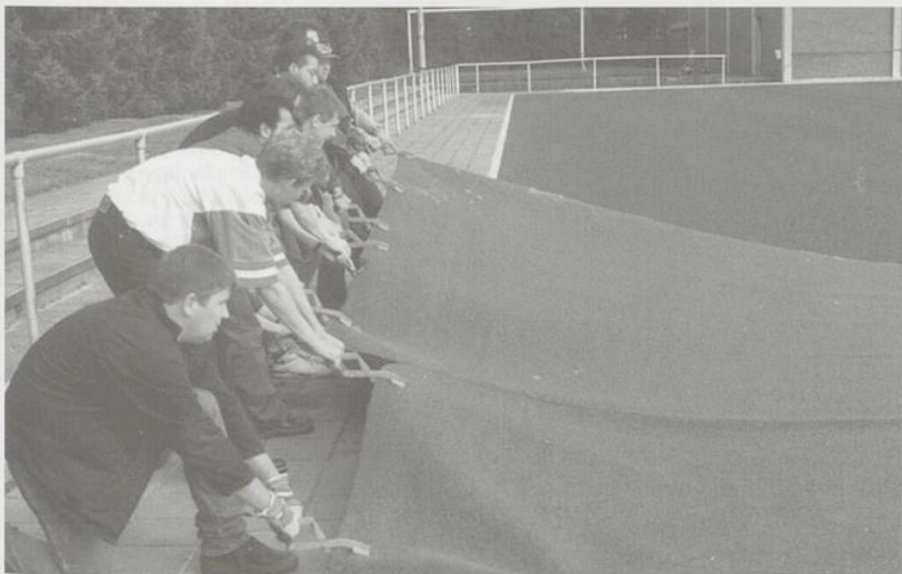
Der Kunstrasen wird verlegt – Bild: VfL
