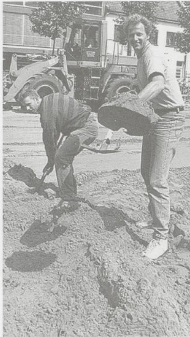
Umbau des Waffenplatzes zum Strand für das erste Internationale Beach-Volleyballturnier 1995 – Bild: NWZ vom 14. Juni 1996
