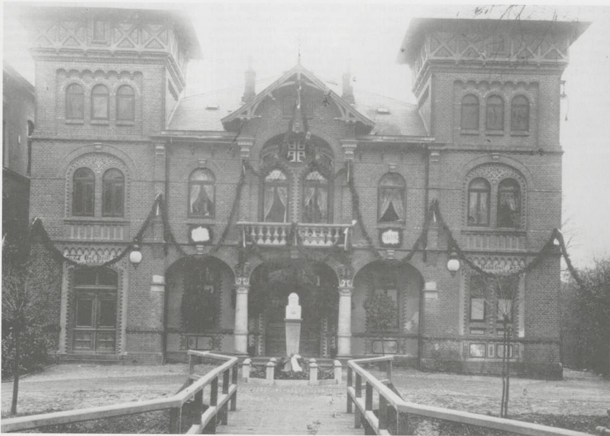
Die 1890/91 erbaute alte Turnhalle des OTB am Haarenufer im Jahr 1909. Eine Holzbrücke über die Haaren führte unmittelbar auf das Hallenportal zu – Bild: OTB
