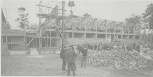
Richtfest für die neue OTB-Turnhalle am Haarenufer – Bild: OTB
