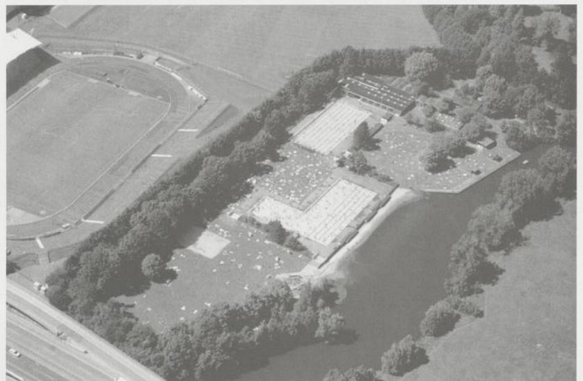
Blick aus der Vogelperspektive auf das zu einem sportgerechten Freibad ausgebaut Huntebad – Bild: Stadt Oldenburg
