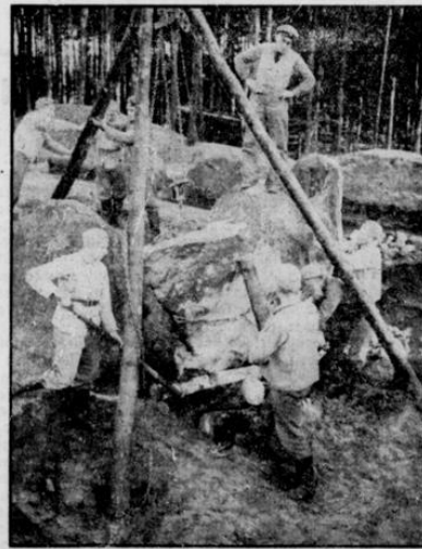
Aufrichten eines Einfassungssteines Aufnahmen (S): Bodenstab, Spitzer
