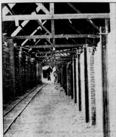
Gang neben dem Tunnelofen
