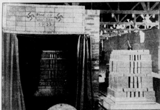
Eingang zum Tunnelofen (links), Platten auf dem Förderwagen (rechts)
