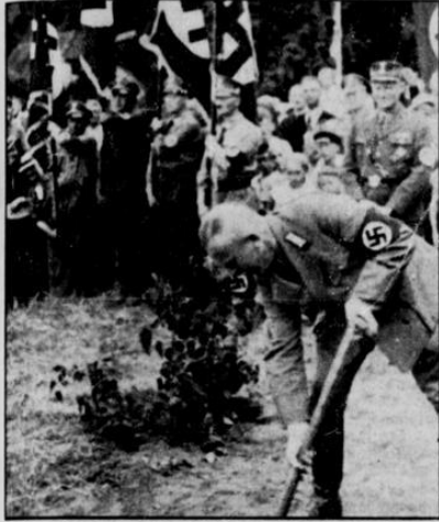
Staatsminister Pauli beim ersten Spatenstich für den Bau des neuen Amtshauses
