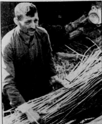
Bund um Bund wird von dem Handlanger aufs Dach gebracht
