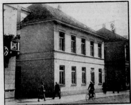
Die Verwaltung zieht in dieses Haus Ecke Theaterwall und Gaststraße
