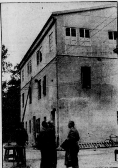
Das Kulissenhaus wurde aufgestockt, Blick von der Südseite
