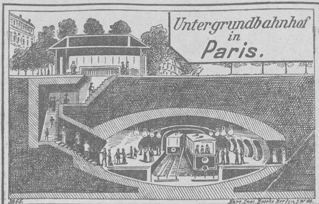
Der Längsquerdurchschnitt der Pariser Untergrundbahn unterscheidet sich wesentlich von der Berliner Untergrundbahn. Während letztere einen vierseitigen Längsquerdurchschnitt aufweist, zeigt die Pariser Stadtbahn einen im Bogen geführten, sehr breit gehaltenen Querschnitt, was mit der Tatsache zusammenhängt, daß dort vielfach unterirdische Abweigungen und Kreuzungen stattfinden, die ein breiteres Profil des Bahntunnels erforderlich machen.
