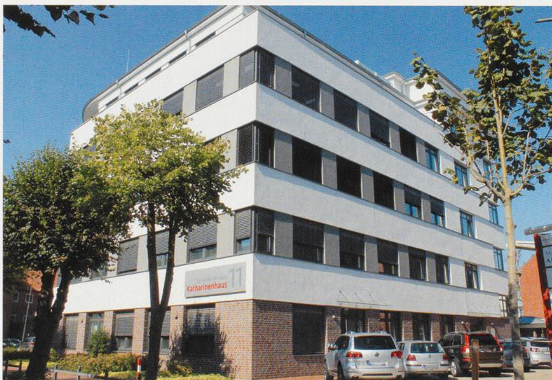
Abb. 6: Der Krankenhaus-Komplex wurde in mehreren Bauabschnitten erweitert: hier das Ärztehaus an der Marienstraße. Foto: W. Klohn
