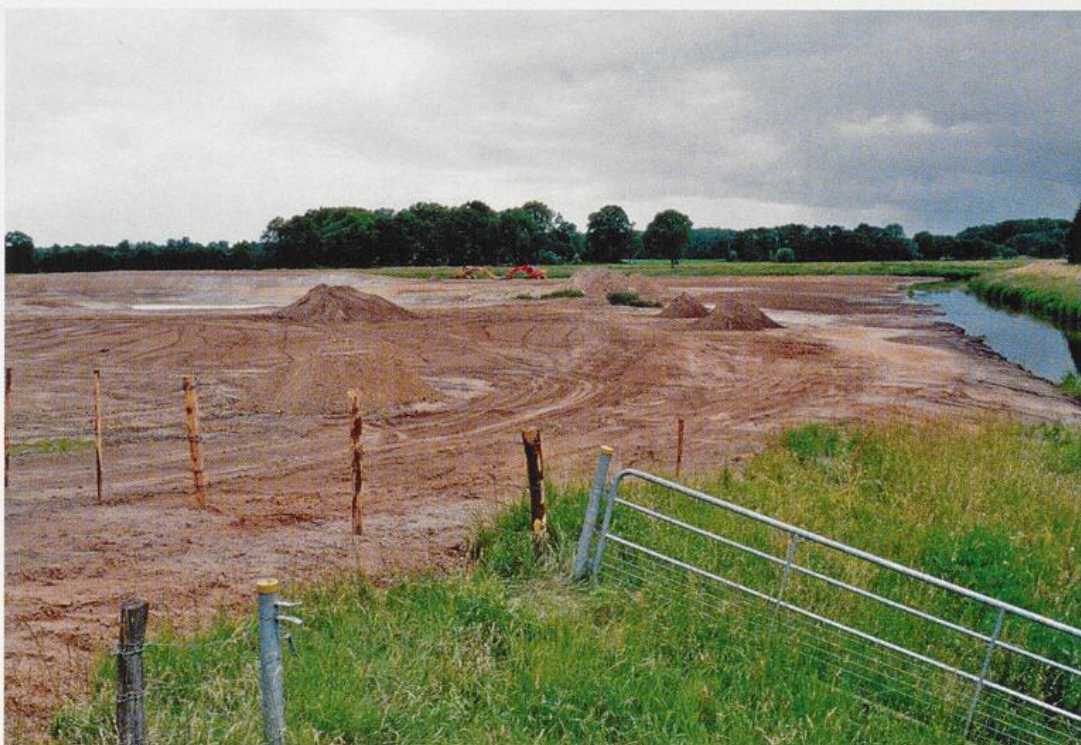
Abb. 2: Die Fläche während der Bauphase 2009
