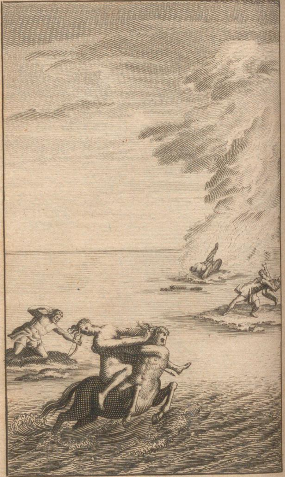
Travaux et mort d'Hercule.
