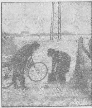
Der Kabelbrunnen in Budow-Ort bei Berlin auf dem Wege nach Königs-Wusterhausen, von dem aus am Silvesterabend die Rundfunkansprache des Reichspräsidenten unterbrochen wurde.
