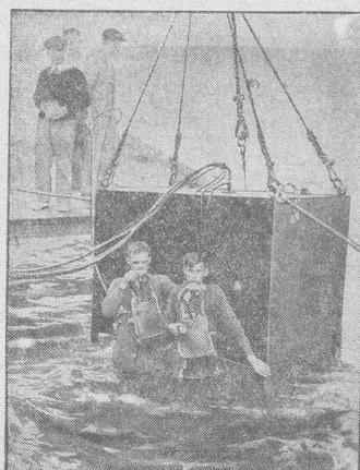
Das gekunkene englische Unterseeboot „M 2“ war mit den modernsten Rettungsapparaten ausgestattet. Jeder Mann der Besatzung besaß einen sogenannten „Tandem“, ein Rettungsgerät, das mit einem Sauerstoff-Apparat versehen ist und den Eingeschloffenen von selbst an die Oberfläche des Wassers zieht. Ansehend erregte sich die Katastrophe des englischen U-Boots so schnell, daß es den Eingeschloffenen nicht mehr möglich war, sich durch die Torpedoausstöße in Sicherheit zu bringen.
