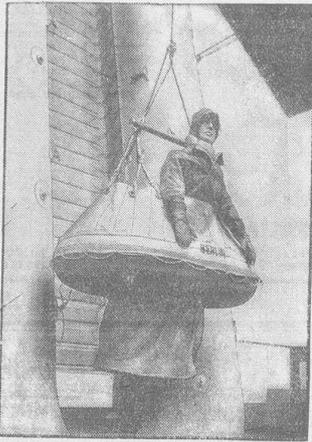
Eine Höhenboje, der „Fahrstuhl“ des „Graf Zeppelin“, der eine Verbindung vom schwebenden Luftschiff mit dem Eis oder Wasser ermöglichte.
