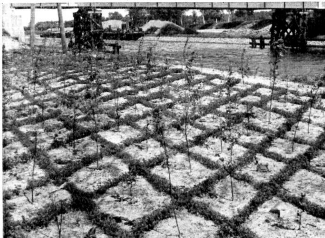
Abb. 13: Bepflanzung des südlichen Seitendamms mit Gehölzen und Festlegung des losen Sandbodens durch Lupinen-Ansaat.
