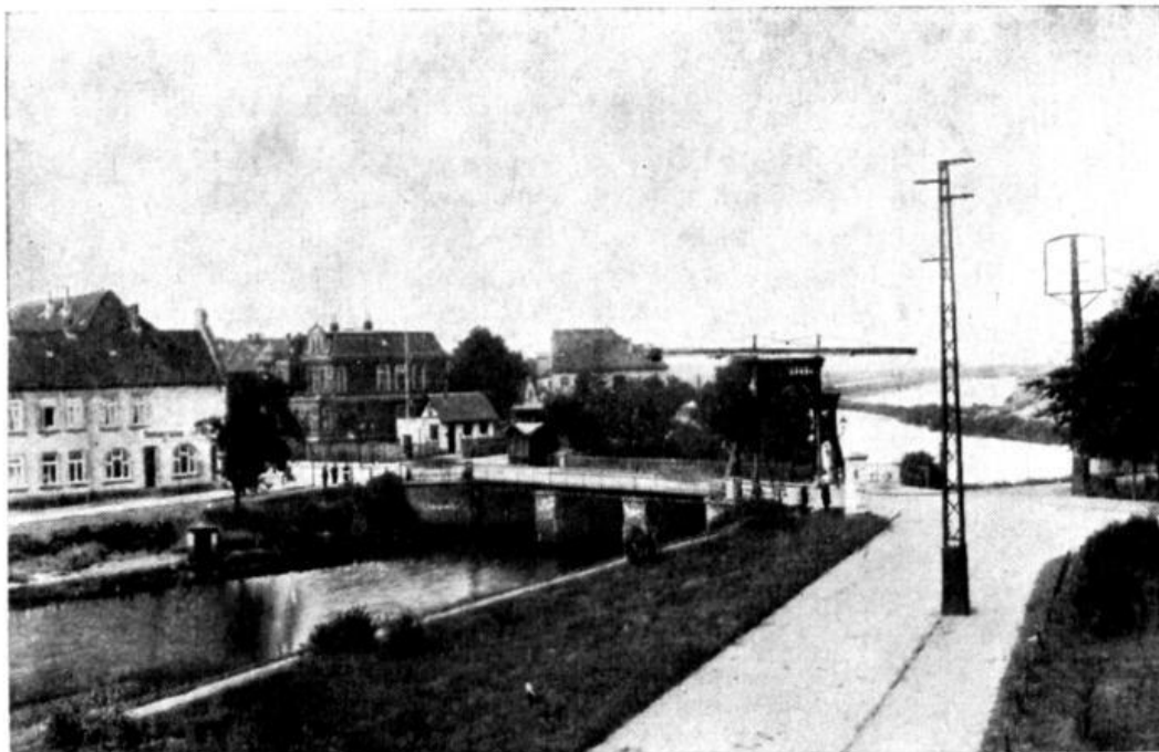
Abb. 10: Cäcilienbrücke N. 2, 1925; im Hintergrund: neuer unterer Schleusen-Vorhafen mit Trenndamm.
