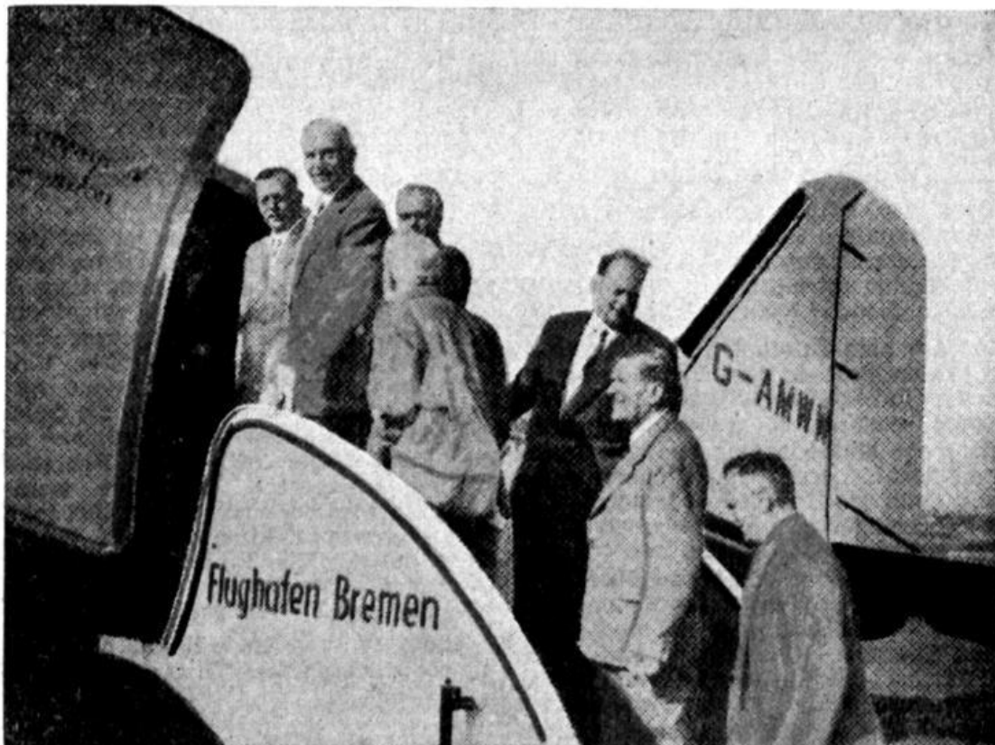
Abb. 5: Bei den Flügen des 5. September 1955 auf dem Flughafen Bremen. Von links nach rechts: Verwaltungspräsident Dannemann (Verw.-Bez. Oldenburg), Oberreg.- u. Vermessungsrat Diekmann (Vermessungsdirektion Oldenburg), Dr. Westerhoff (Amt für Landesplanung bei der Regierung Oldenburg), davor Regierungspräsident Hamann (Reg.-Bez. Ostfriesland), Museumsdirektor Dr. Hartung, Oberlandwirtschaftsrat Spitz (Landwirtschaftskammer Oldenburg), Dr. Schettler (Deutsche Vacuum Öl A. G.) (Foto: Bremer Nachrichten)
