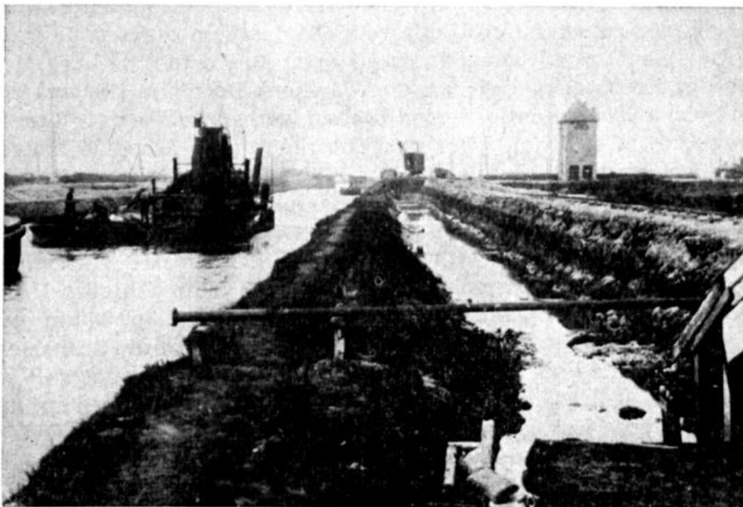
Abb. 29: Verbreiterung, km 13 (Wendeplatz). Im Hintergrund alte Schleuse III an der Vehne.
