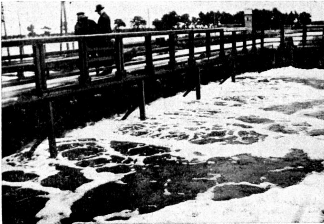
Abb. 31: Entlastung aus dem Brückenkanal in die Soeste.
