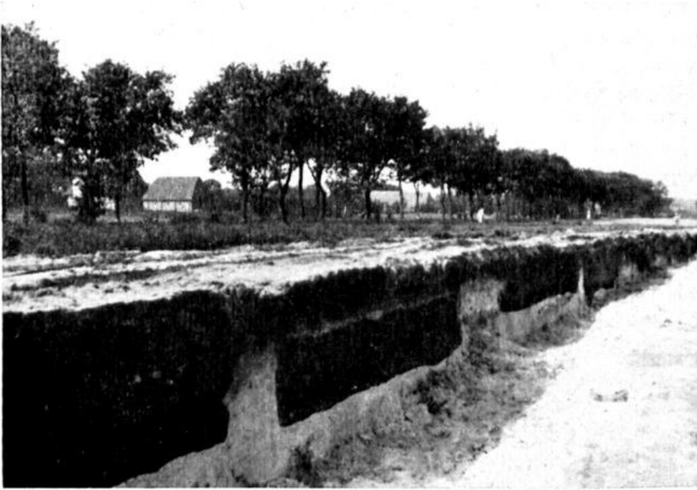
Abb. 3: Längsschnitt durch die „Gräben“ eines Plaggenbodens in Westerscheps. Osten links, Westen rechts.
