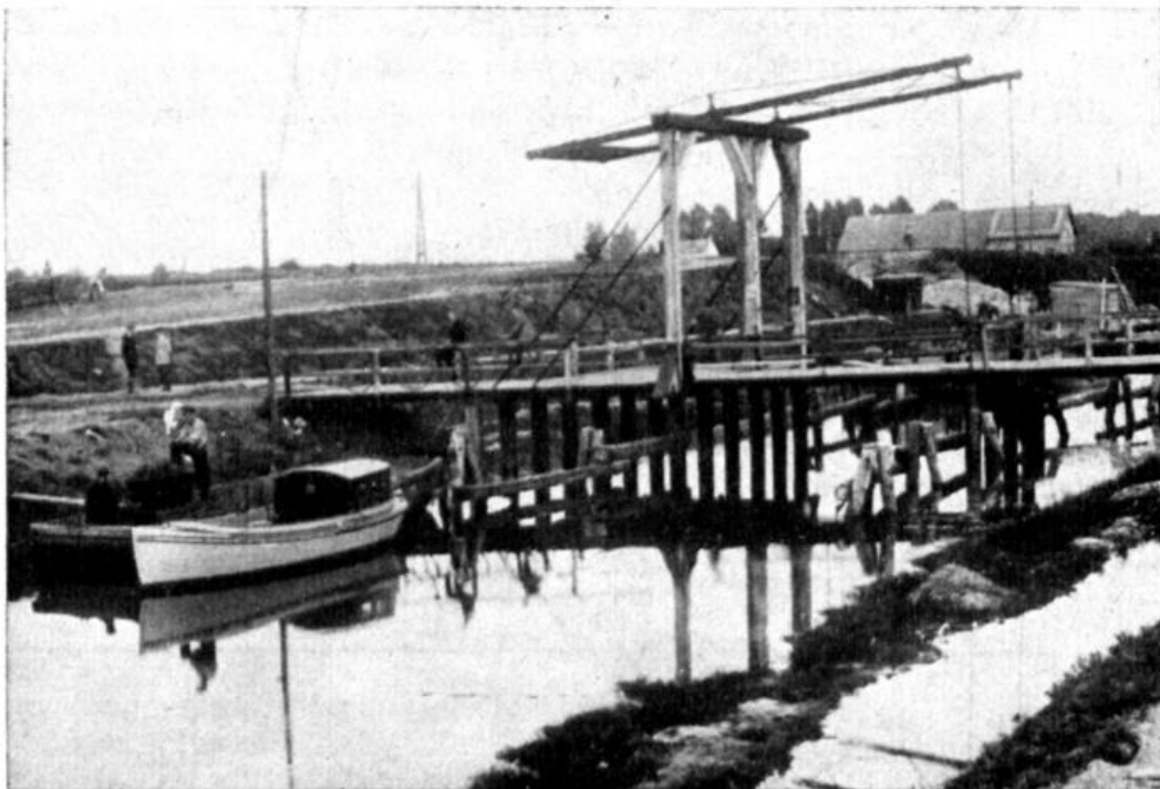
Abb. 17: Schiefe Klappbrücke bei km 11 (Klein-Scharrel).
