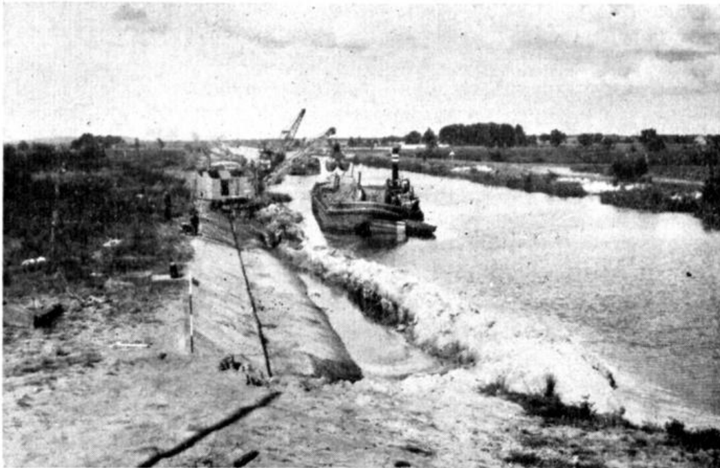
Abb. 7: Aushub des Südufers 1 : 3 im Schutze eines provisorischen Erddammes.
