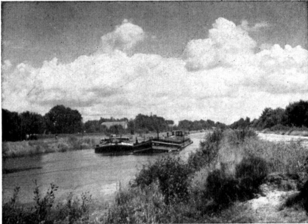
Abb. 5: Der Küstenkanal bei Mosleshöhe vor dem 2. Ausbau.
