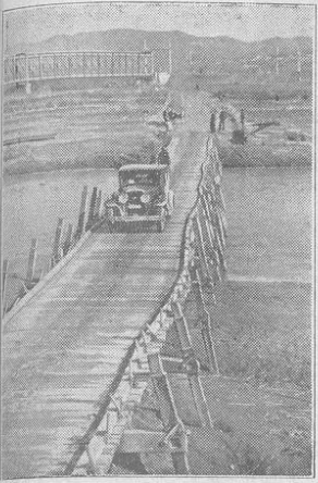
Oben Bild zeigt eine Holzbrücke über den Fluß bei Barcelona, die an Stelle der zerstörten Hauptbrücke errichtet wurde, bis diese wiederhergestellt werden kann. (Spezial-Bilderdienst-W)
