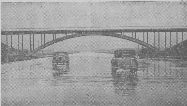
Neue Retfordstrecke auf der Berlin-Weiziger Autobahn
