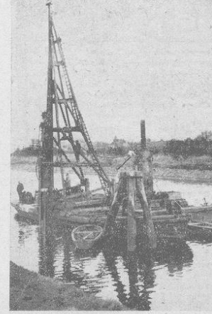
Der Eisenpfahl wird vom Dampfhammer eingerammt
