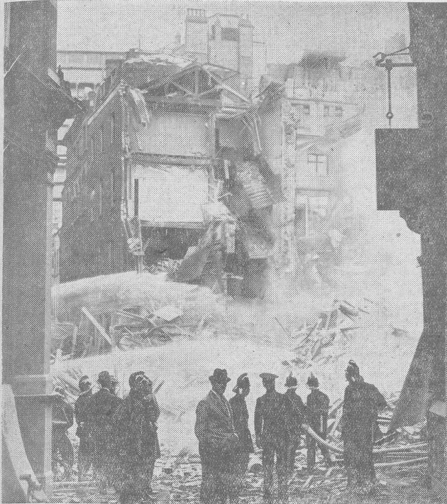
In der Londoner City ereignete sich — wie berichtet — in dem Viertel zwischen St. Pauls-Kathedrale und der Themse eine gewaltige Gasexplosion, bei der riesige Zerstörungen angerichtet wurden. Nicht weniger als 200 Häuser wurden beschädigt und 150 Personen mehr oder weniger schwer verletzt.
