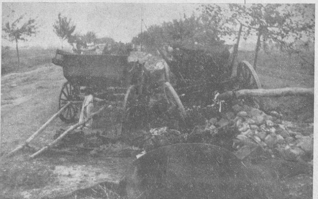
Auf einer Rückzugsstraße der Polen. Rechts und links der Straße zerstörte Kolonnen
