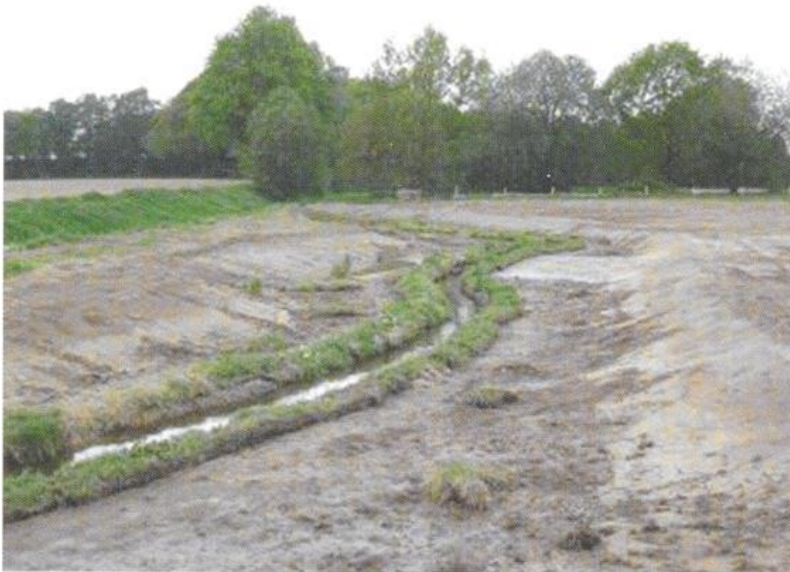
Abb. 1: Befestigung der Ufer und Anlegung der Auen
