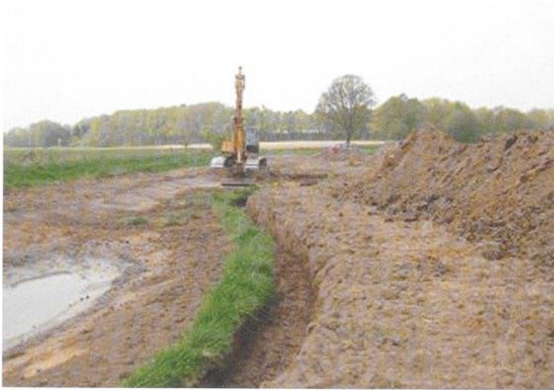
Abb. 2: Befestigung der Ufer
