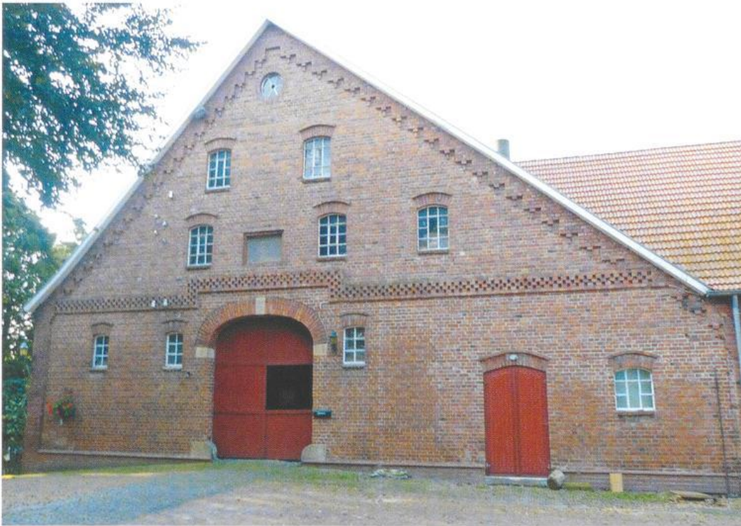
Abb. 4: Backsteinhistoristische Fassadengestaltung der Wirtschaftsgiebelseite eines 1901 erbauten Bauernhauses in Cappeln, 2014 Foto: Michael Schimek
