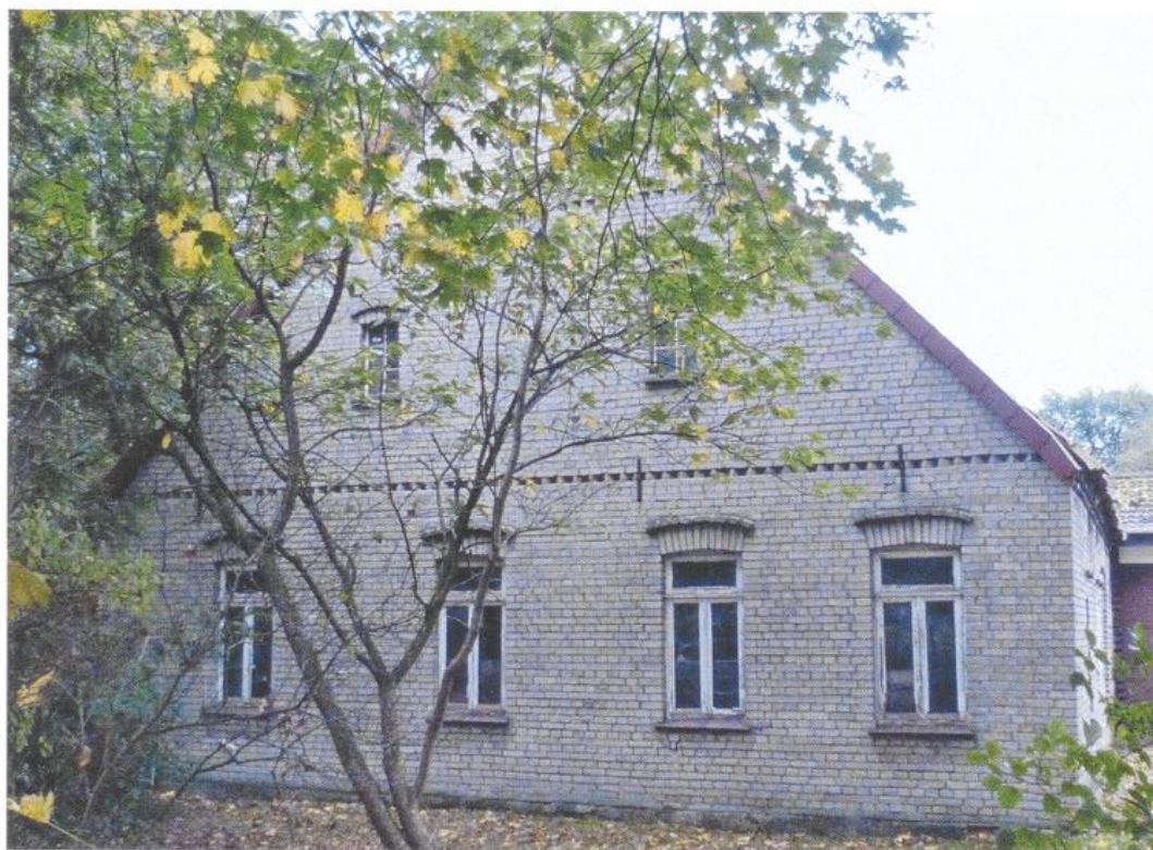
Abb. 3: Ein frühes und seltenes Beispiel für ein auch in den Außenwänden aus Kalksandstein errichtetes Wohn- und Wirtschaftsgebäude im Stil der Historismus, Beverbruch, 2014
