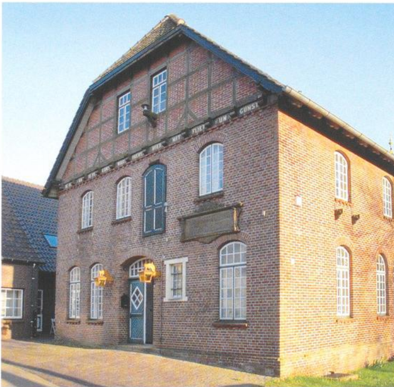
Abb. 3: Die Restaurierungswerkstatt in Neuenburg, Gemeinde Zetel
