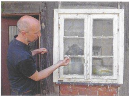
Abb. 4: Überprüfen eines Holzfensters vor Ort, um es möglichst zu erhalten
