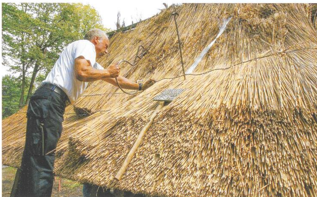
Abb. 2: Dachdecker Bernt Vögel beim Ausbessern eines Reetdaches im Museumsdorf
