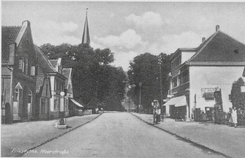
Abb. 9: Die Friesoyther Moorstraße vor der Zerstörung
