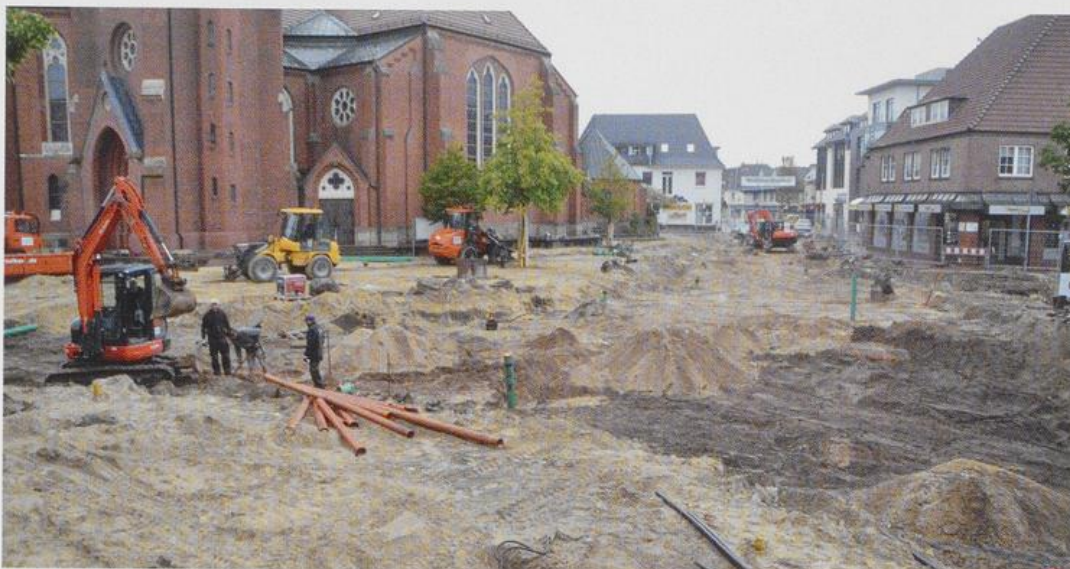
Abb. 2: Die Kreuzung an der St. Marienkirche in Friesoythe wird komplett saniert.
