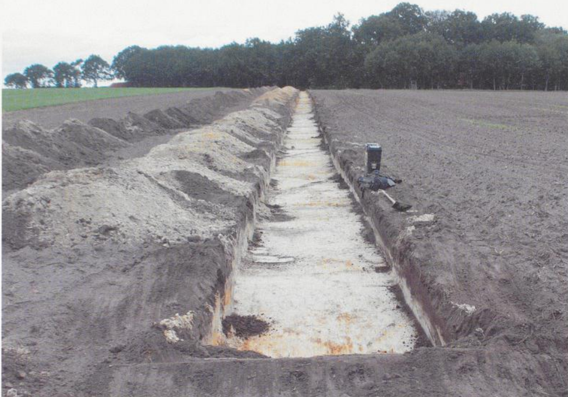
Abb. 1: Suchgraben, nordsüdlich ausgerichtet
