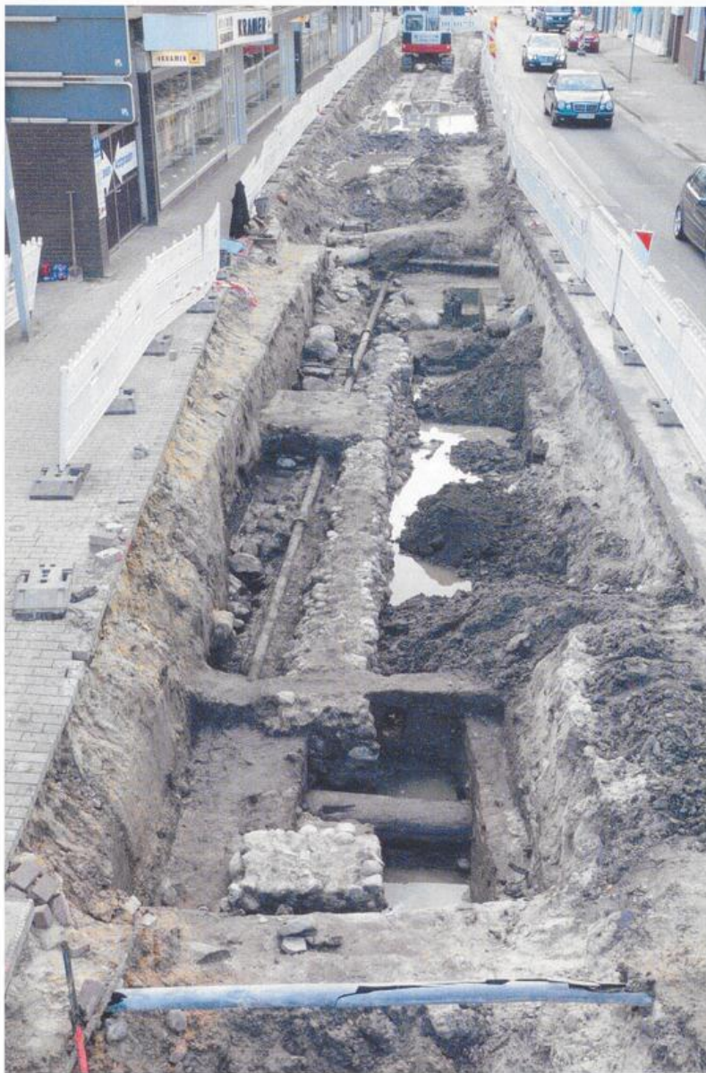
Abb. 7: Die Fundamente des Bremer Tores
