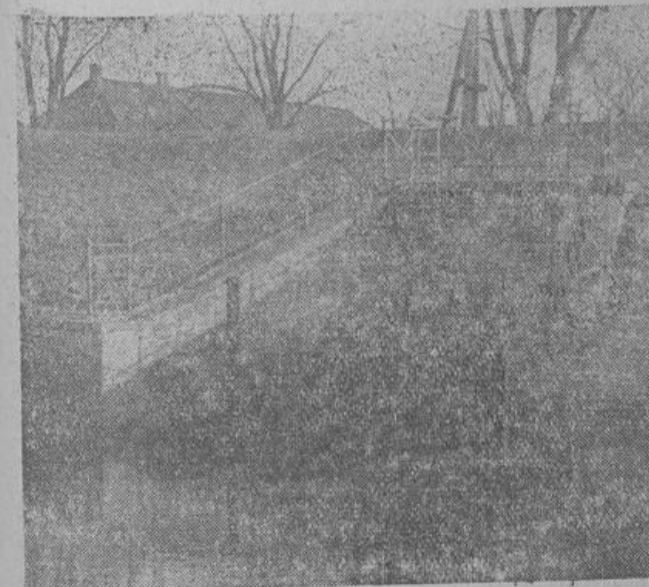
Das Thedingager Vorwerk
