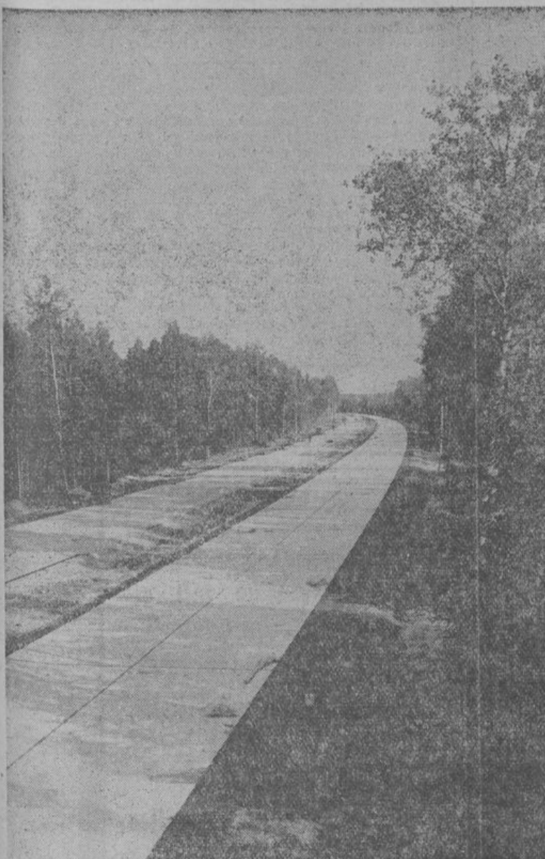
Nach dem berühmten ersten Spatenstich
