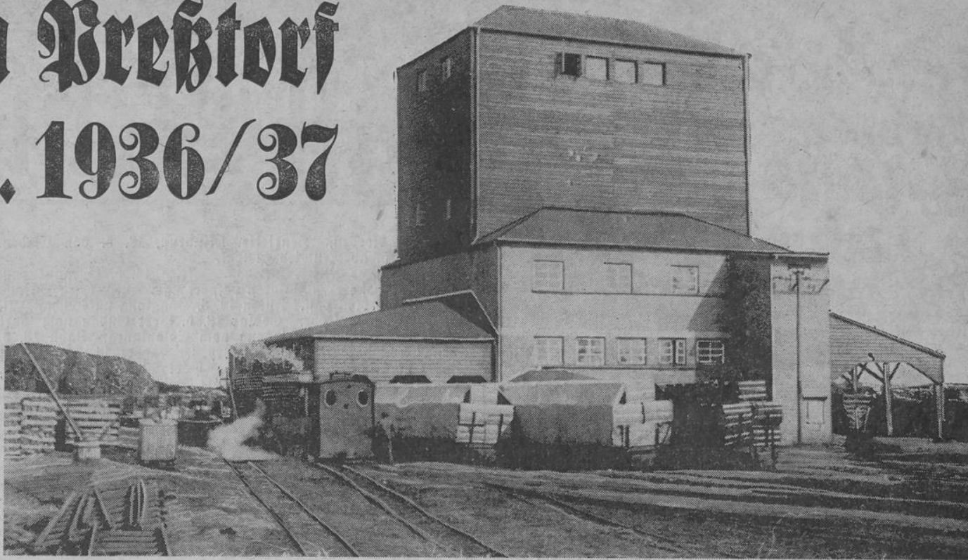
Weithin sichtbar erhebt sich das Torfwerk aus der weiten Fläche des Klostermoors. Durch die Aufträge des WSW. wurde dieses Werk erst wieder lebensfähig.
