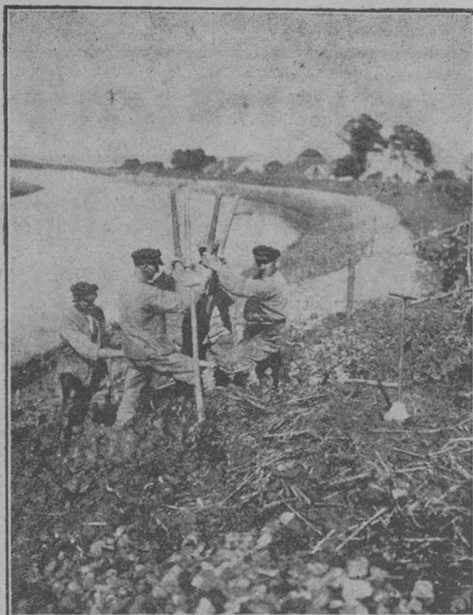
Arbeitskameraden am „Stampfer“, einem schweren Holzblock zum Feststampfen des Deiches.
