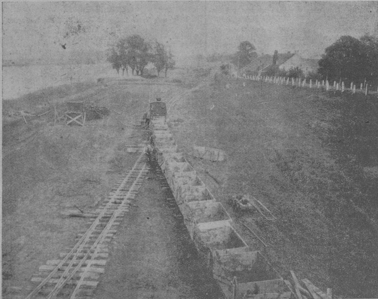
Der „Deichexpress“ rollt an. Leere Loren werden zur Schachtstelle gefahren. Feldbahnweise liegen den Deich entlang, an dem sich ein eigenartiger „Eisenbahnverkehr“ entwickelt hat. Bei jeder Baustelle laufen zwei Lokomotiven und etwa 20 bis 25 Loren zur Beförderung des Baukoffes.
