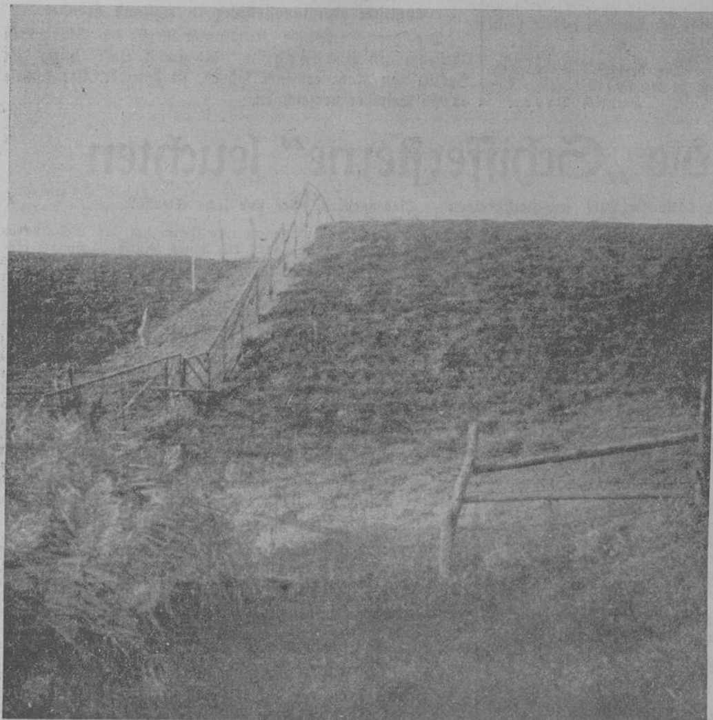
Der Kanalpolder grenzt unmittelbar an Holland. Auf unserm Bild sieht man deutlich, daß der neue Polderdeich (rechts des Grenzgitters) bedeutend höher und breiter ist als der holländische Deich. Der holländische Teil des Kanalpolders ist nur ganz klein
