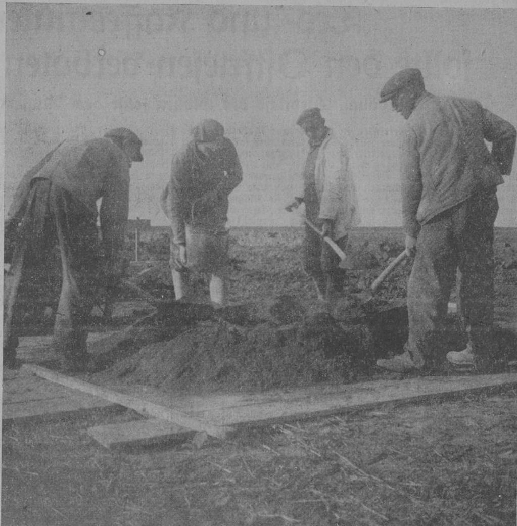
Ein neues Bauerndorf entsteht im Kanalpolder. Das gibt Arbeit und Brot für rund 100 Bauhandwerker und Bauarbeiter
