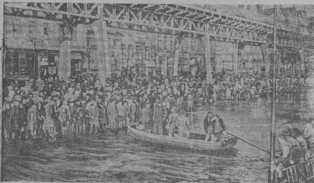
Links: Sturmflut an den deutschen Küsten. Der starke Nordweststurm, der über der Nordsee tobte, hat gewaltige Wassermassen in die Elbe hineingedrückt, so daß die Straßen in der Nähe des Hamburger Hafens überflutet sind. Nur mit Booten kann der Verkehr aufrechterhalten werden. - Rechts: Die Fahne der spanischen Phalangisten. Unter diesem Zeichen, als dem Wappen des neuen Spaniens, wird der Freiheitskampf geführt. Die fünf Pfeile symbolisieren die fünf alten Königreiche, das Doppelkreuz ist das Zeichen der Vereinigung Spaniens unter Ferdinand und Isabella. - (Weltbild, A.)
