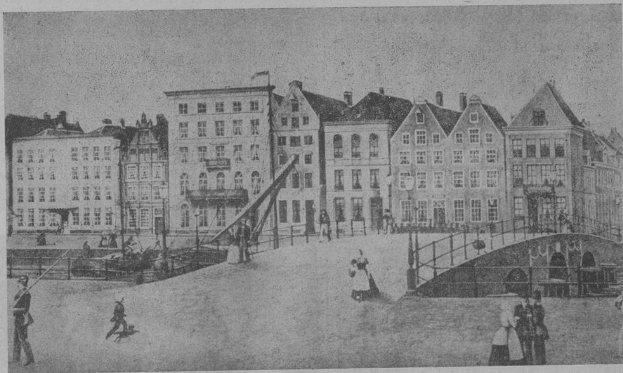
Die alte Rathausbrücke
