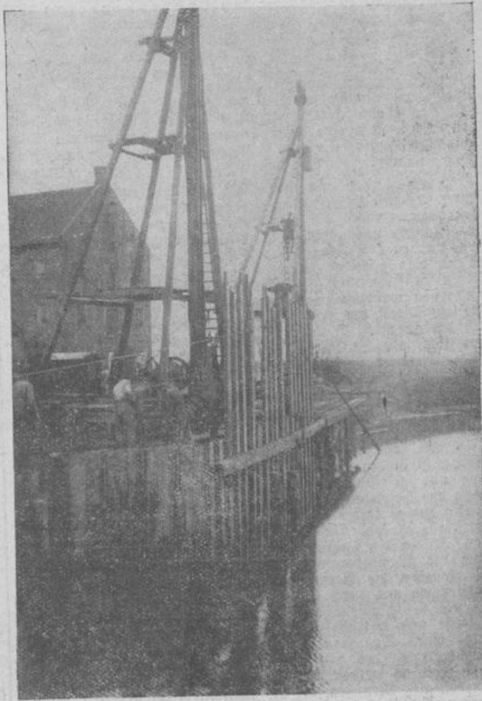
Bild rechts: Der große Rammerturm, mit dessen Hilfe die Spundbohlen der Kajungen eingerammt werden.
