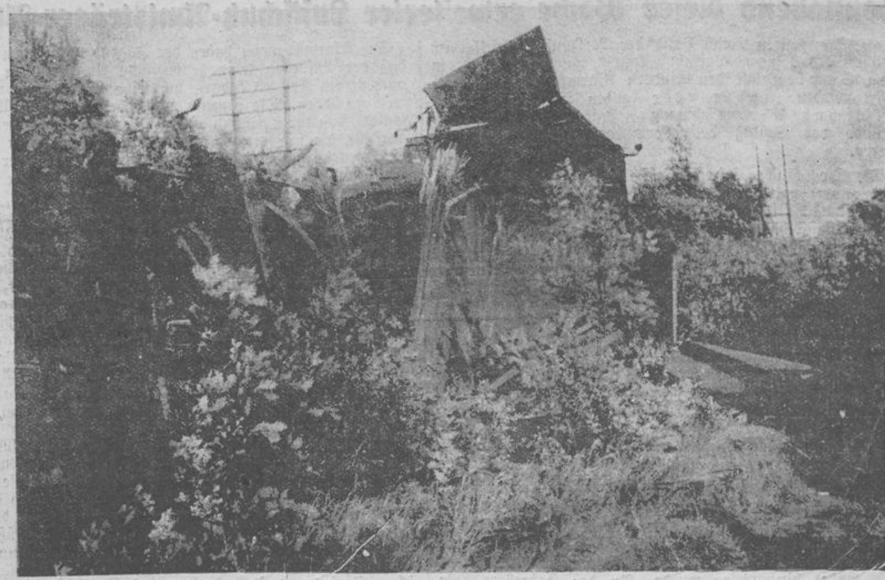
Unsere Aufnahme, die einige Zeit nach dem Zusammenstoß des D-Zuges mit dem Güterzug bei Fißum gemacht wurde, zeigt den zertrümmerten, aus den Schienen gehobenen Güterwagen an der Böschung des Eisenbahndammes. Es hat sehr viel „Kleinholz“ gegeben, doch wurde auf dem Güterzug niemand verletzt. „DZ“-Bild. Aufnahme: Berlin.
