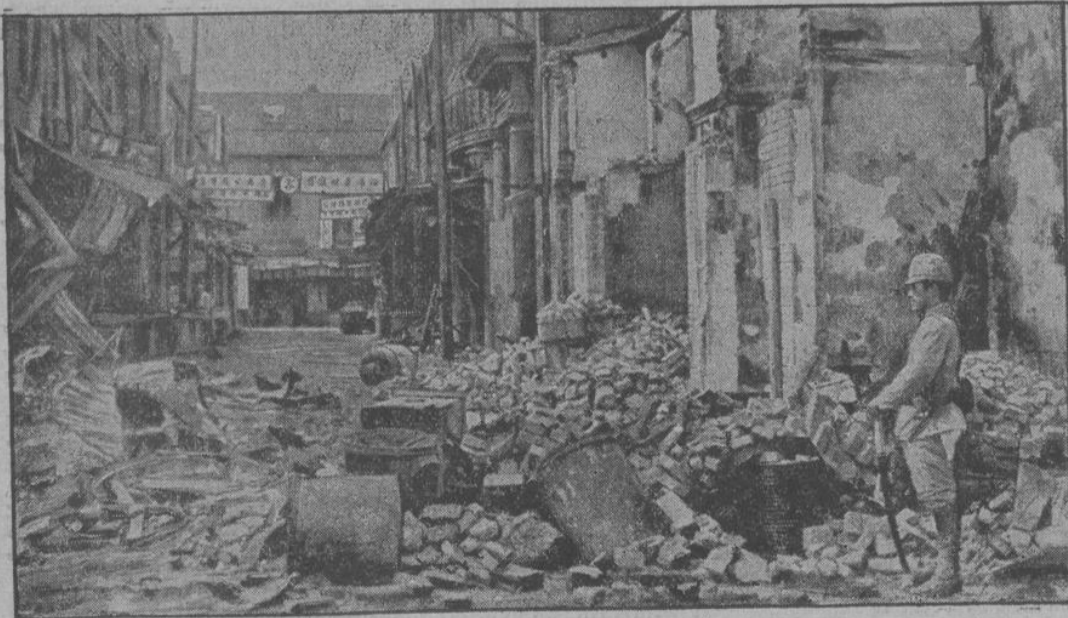
So sieht es im Schanghai-Bahnhofsviertel aus
