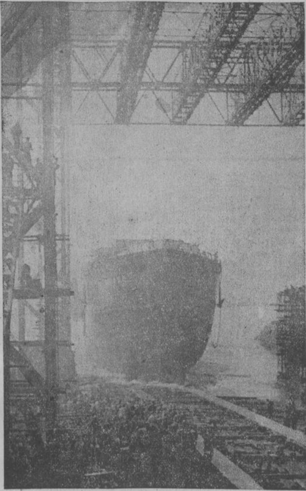
Frachtdampfer „Brage“, Spezialschiff für Erztransporte, 9300 Tonnen (Nordseewerke)
