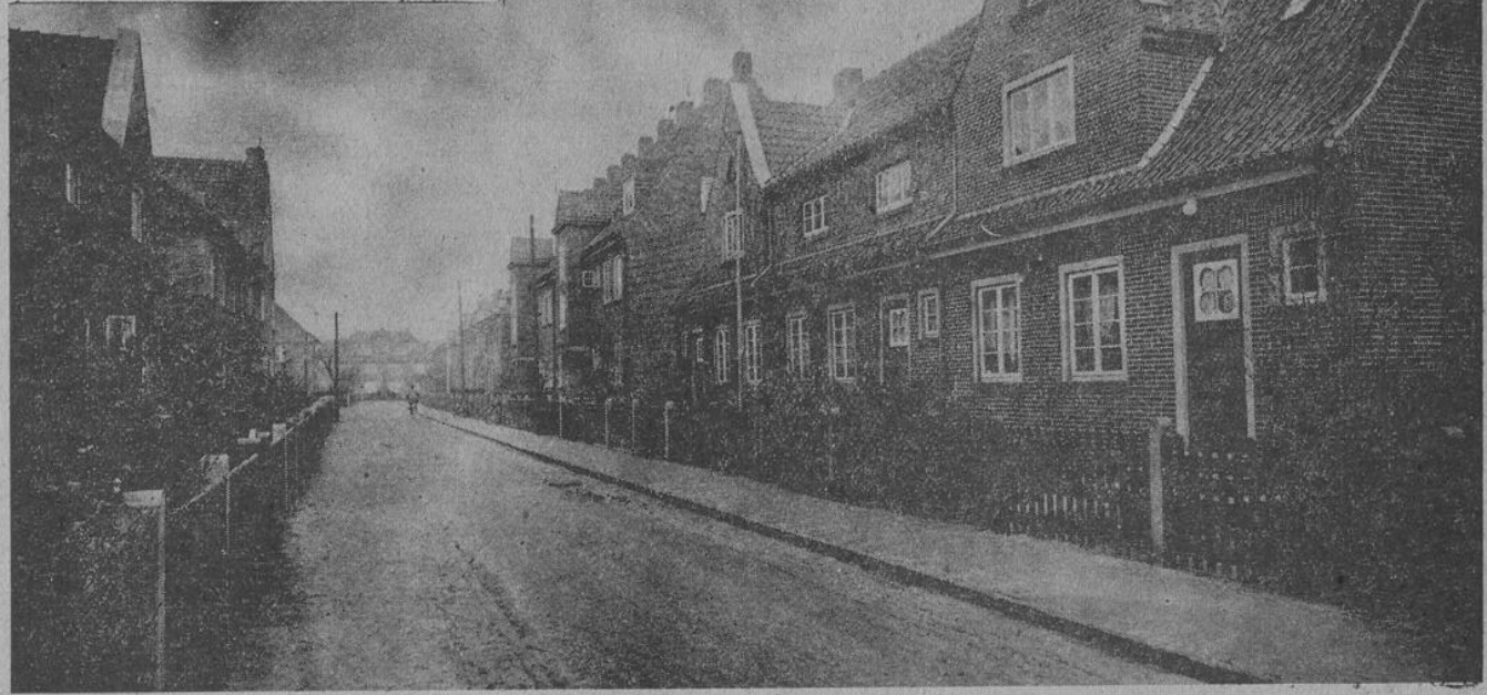
Neue Wohnstraße am Pulverturm zu Leer — So wohnt man gesund
