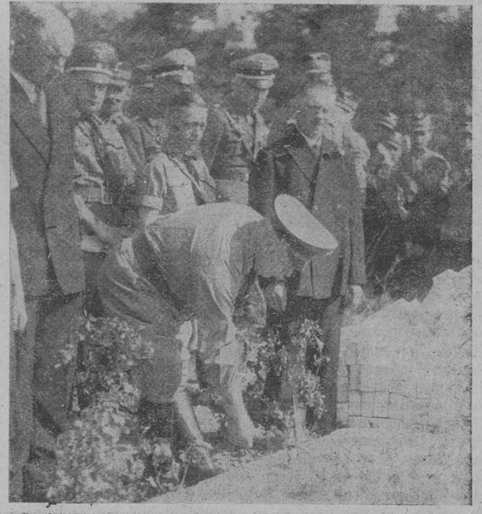
Kreisleiter Buscher vollführt drei Hammerschläge zur Einmauerung der Urkunde in den Grundstein des neuen HJ-Heimes.
