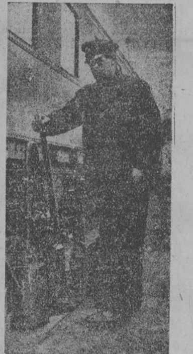
Wer gut schmirt, der gut fährt! Eine Pumpanlage auf dem Bahnsteig des Rangierfeldes sorgt dafür, daß das Schmieröl zum Auffüllen der Achsenlasten ständig bereit ist.
