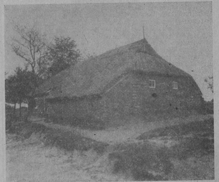
2. Kolonistenhaus in Iheringsohn (Kreis Aurich) mit vollem Strohdach, Samm und Sammbrett (Klepple) mit Maljann einfacher Form. 2 Bilder: Archiv Rink. (D.R.)
