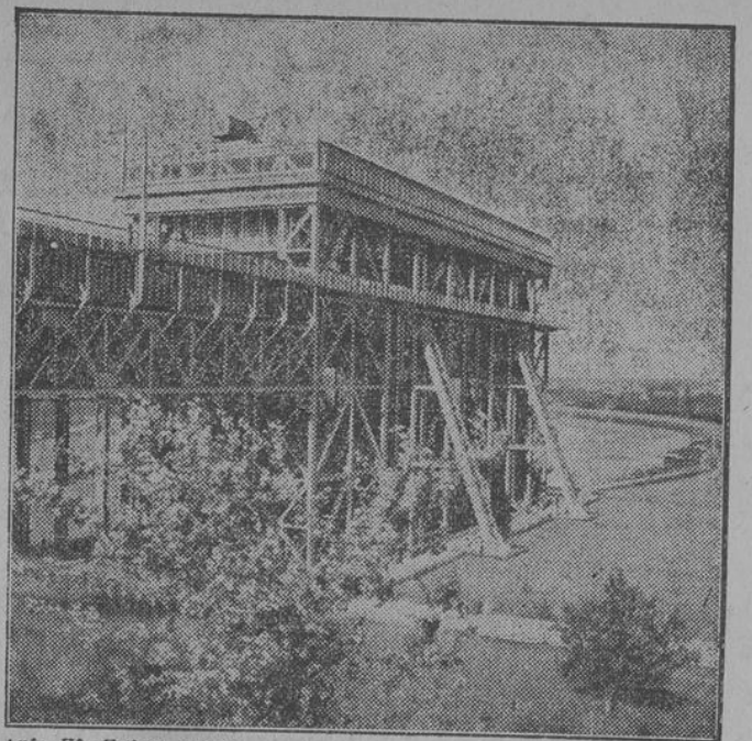
Aufn. Ufa-Hafner (235 K.) Der größte Fahrstuhl der Welt Unser Bild zeigt das Schiffshebewerk Niederfinow am Hohenzollerkanal, das einen Höhenunterschied von 36 Meter zwischen der Savel und der Oder überbrückt. Der Finowkanal, mit dessen Bau im Jahre 1743 auf Veranlassung Friedrichs des Großen begonnen wurde, umgeht das Hindernis und benötigt nicht weniger als siebzehn Schleusen, um den Höhenunterschied zu überwinden. Aus dem neuen Ufa-Kulturfilm „Der größte Fahrstuhl der Welt!“
