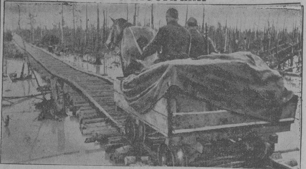
Sie ist fast vollständig aus dem Baustoff der großen Wälder Sowjetrußlands gebaut. Sie bildet eine einfache und leicht auszubauende Verbindung zwischen der Hauptkampflinie und den Nachschublageren. PK-Aufnahme: Kriegsberichtler Rynas (Atl.)
