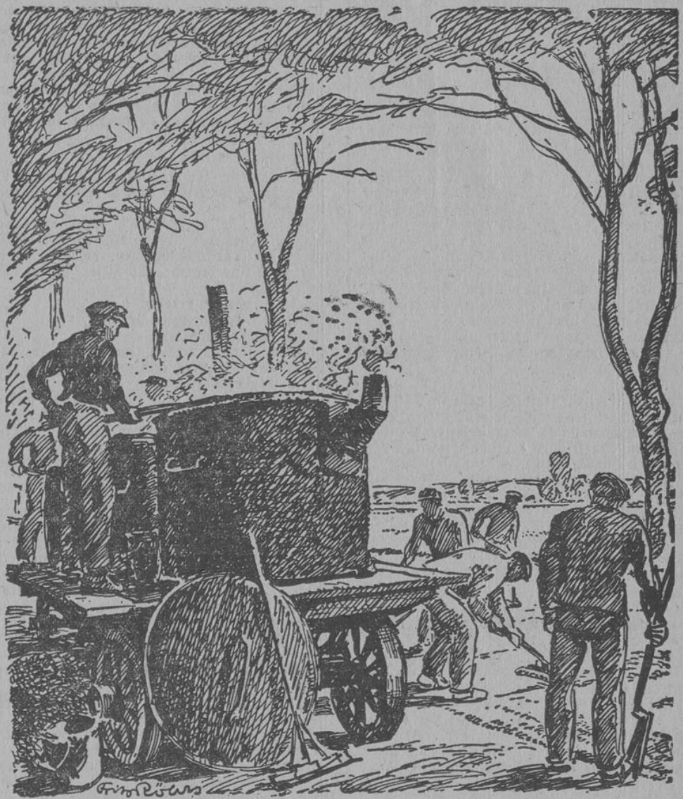
Eine Straße wird gebaut
