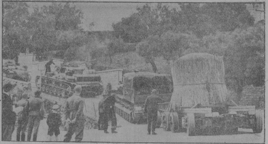
Eine Panzorkuppel wird zur Baustelle befördert. Bei Steigungen reichen oft die Zugmaschine und ein Panzer nicht aus. Da muß dann noch ein zweiter Panzer, der sonst hinter dem Spezialfahrzeug angehängt ist, und durch Stoppen und Zurückziehen bei abfallendem Gelände die Transportschwierigkeiten ausgleicht, vorgespannt werden.
