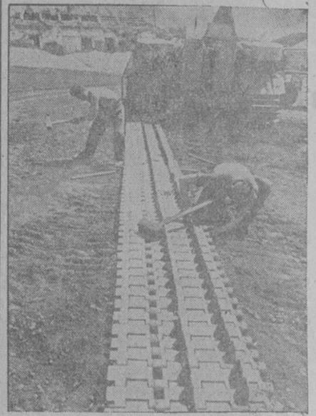
Auch die „Gehwerkzeuge“ eines „Tigers“ müssen gepflegt werden. Jedes Mitglied der Besatzung versteht sich auf die einfacheren Arbeiten der Instandhaltung, wie hier das Festschlagen der Gleiskettenbolzen. (PK.-Aufn.: Kriegsbericht Lohse, HH.)
